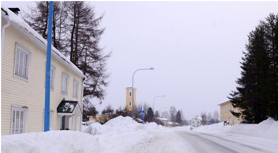
Tien varressa sijaitseva, kuvan oikeassa reunassa puurivin takaa erottuva opettajien asuinrakennus muodostaa osan kulttuurihistoriallisesti arvokasta raittia. Muut arvorakennukset vasemmalta oikealle: Kotirinne, vanha paloasema ja Kilpimaan matkustajakoti.
