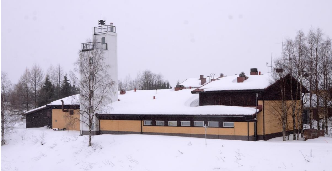
Rakennus kuvattuna Kemijoen ylittävältä sillalta. Tekninen toimisto sijaitsee rakennuksen vasemmassa laidassa ja pelastuslaitoksen tilat oikealla.
