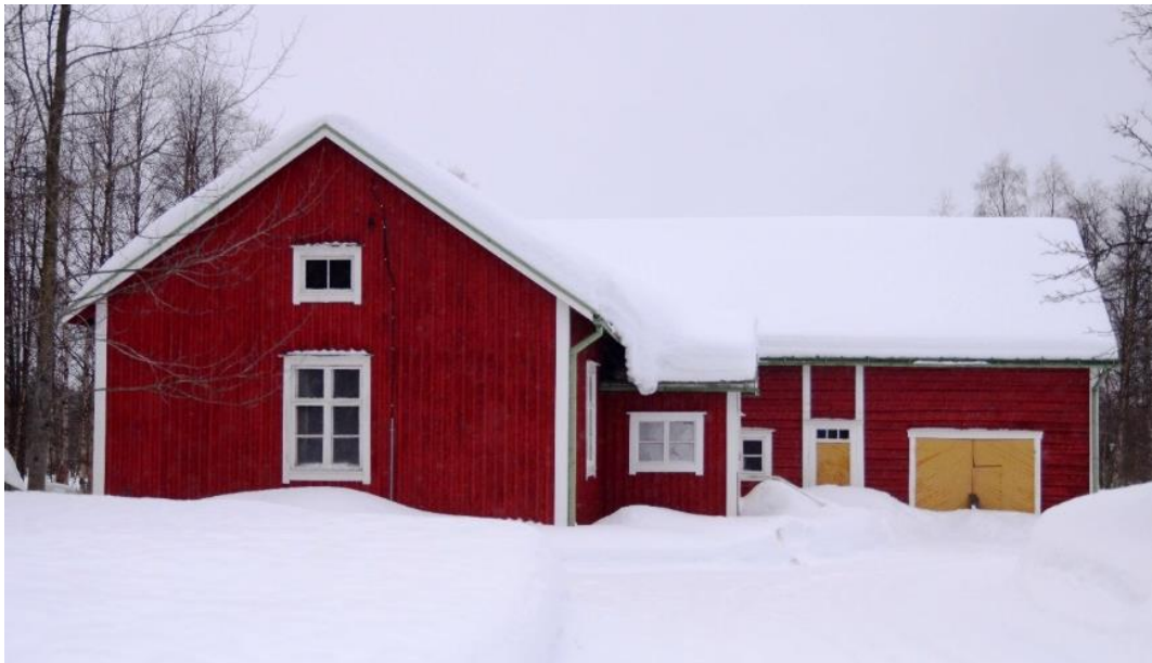
Pappilan pirtti- ja navettarakennus. Julkisivu itään.
