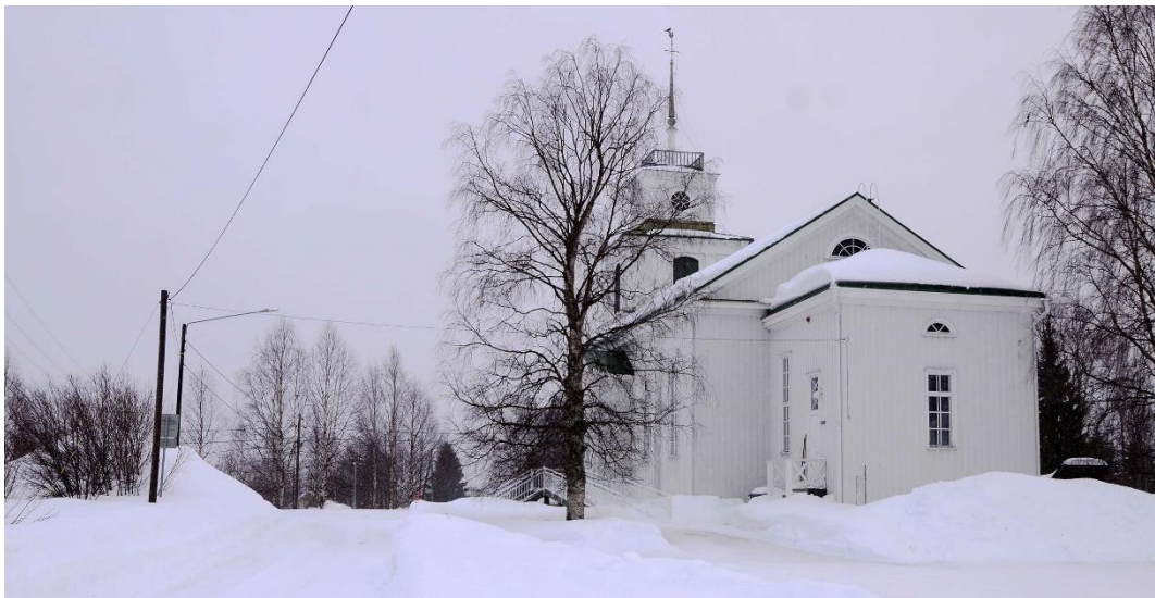
Kirkko pappilan suunnasta kuvattuna. Kuvan vasemmassa laidassa kulkee avaranäkymäinen Kirkkotie.
