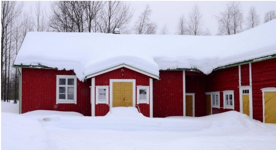
Pappilan pirtti- ja navettarakennus pohjoisesta, saunan edestä kuvattuna.
