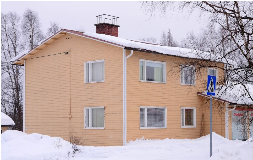
Sodankyläntie 13 luoteesta. Kuvan vasemmassa nurkassa pilkottaa tontilla sijaitseva pieni piharakennus.
