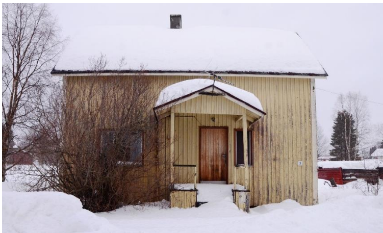
Kirkkotie 3 tienpuoleinen (eteläinen) julkisivu.
