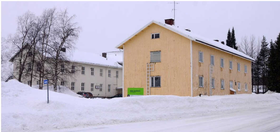
Koulualueen rakennukset muodostavat tunnistettavan kokonaisuuden.
