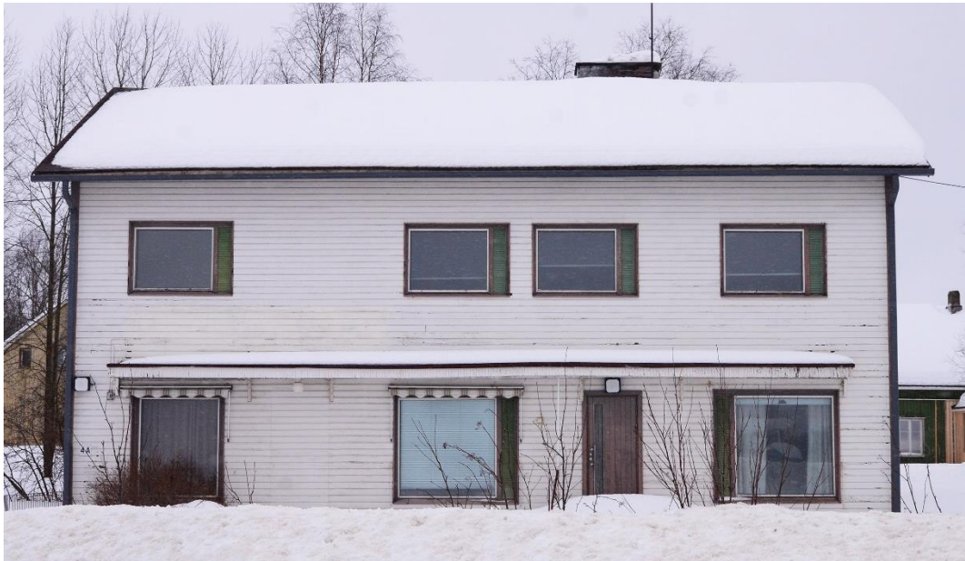
Sodankyläntie 4a:n idänpuoleinen julkisivu (Sodankyläntielle päin).
