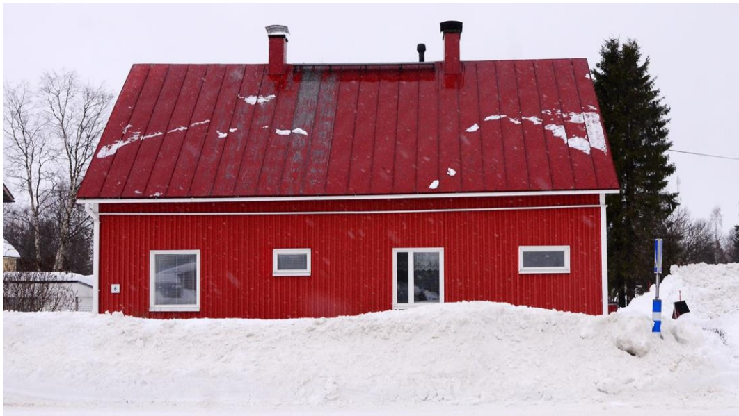
Päärakennuksen Sodankyläntien puoleinen julkisivu.
