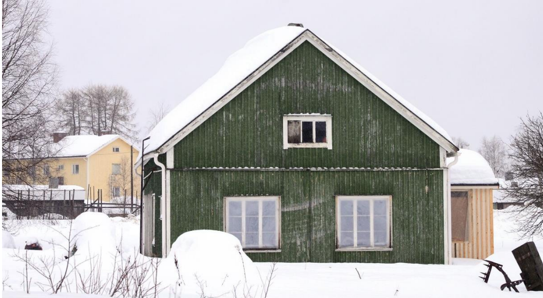
Sodankyläntie 4b:n eteläjulkisivu. Sisäänkäynti on remontissa.
