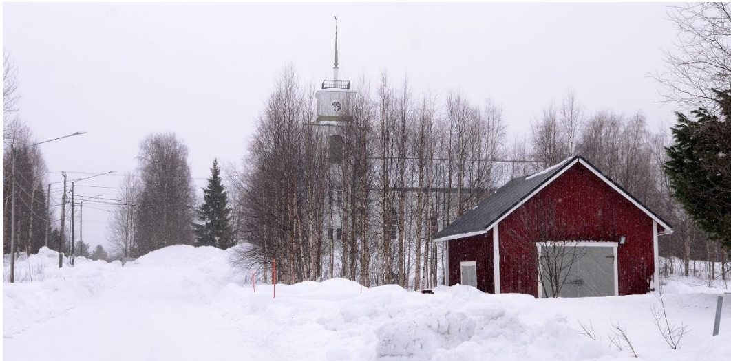
Näkymä kirkolle Turjalantien pohjoispäästä peittyä puuston taakse. Näkymää reunustaa osittain li- säksi Turjalantien varressa sijaitseva pihapiiri rakennuksineen.
