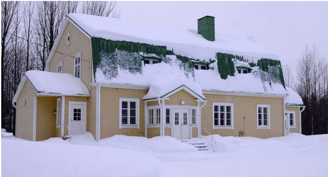
Pappilan päärakennuksen julkisivu pohjoiseen.
