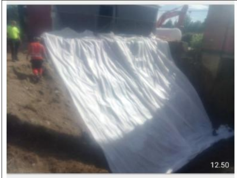
Kuva 2. Suodatinkankaan asennus.
