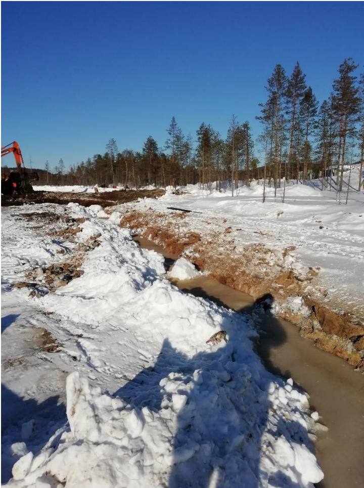
Kuva 4. Altaasta itään johtava oja. Ojaa on kaivettu matalasti suon pintaosaan.
